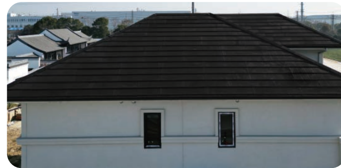
20KW Aufstellungsort: Jiangsu, China Aufstellungszeit: 2022 Projekttyp: Privathaushalte - BIPV
