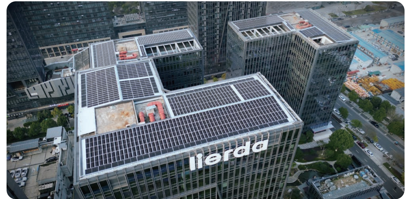
265KW Aufstellungsort: Zhejiang, China Aufstellungszeit: 2024 Projekttyp: Gewerbe-und Industriebereich - BIPV
